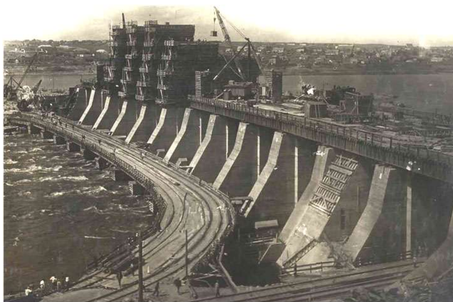
Строительство ДнепроГЭС, 1934 г.
