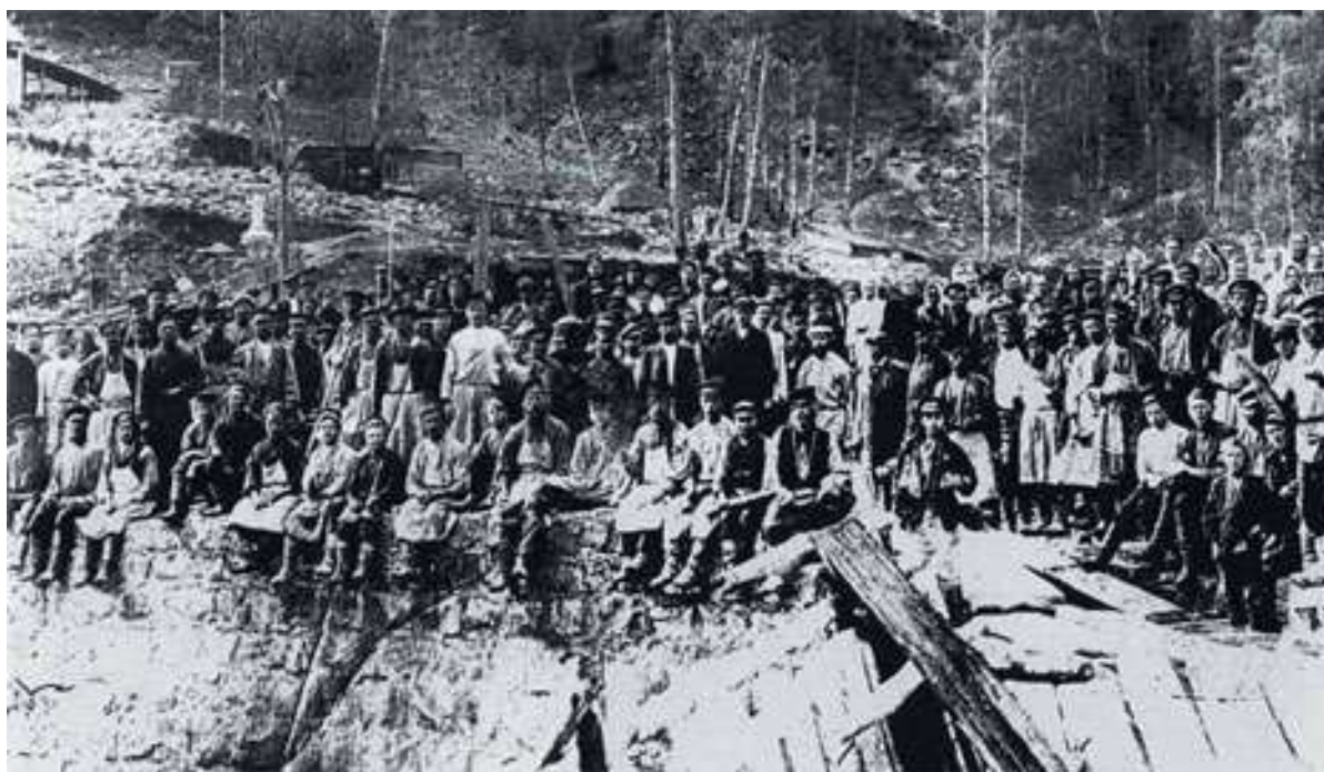
Строители Порожской плотины и завода, 1909 г.
