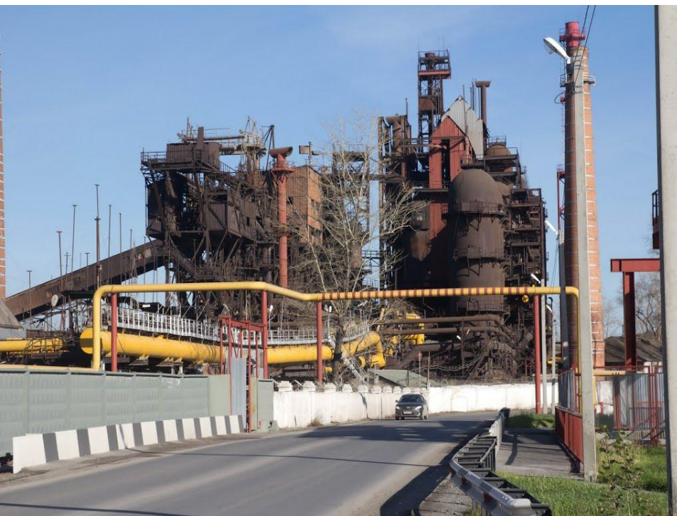
Blast furnace/доменная печь
